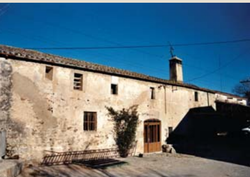
Façana principal del molí d'en Comes. Sota la reixa del terra, la sortida de l'aigua del carcabà.
