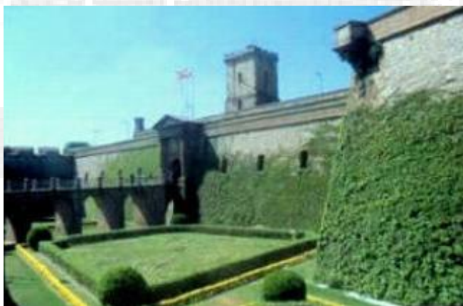
Muralls del castell de Montjuïc (Barcelona)
