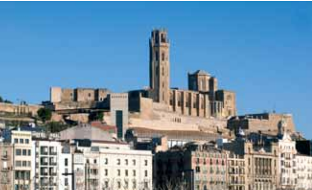
Vista general del turó amb la Seu Vella envoltada pels baluards (Pepo Segura)
